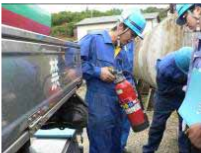
消防設備士が消火器を点検しています。
