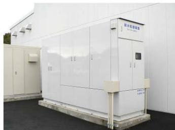
リサイクル型の水処理装置。油水分離し、水を洗車用に再利用されます。
