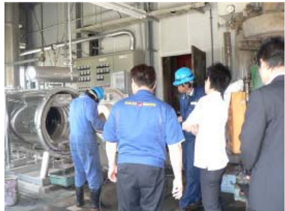
自社工場ボイラー清掃視察
