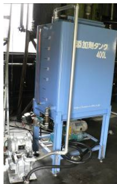
添加剤タンクを新設しました。漏洩防止のために取り付けられた、蓋押え。転倒した場合、内パッキン張りの蓋が、漏洩を防ぎます。（写真上）
