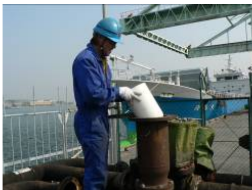
配管内油抜きのため、ピグを挿入します
