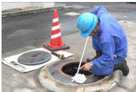
タンク内滞水点検中
