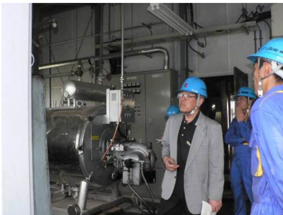
工場内を点検される百瀬顧問(写真中央)
