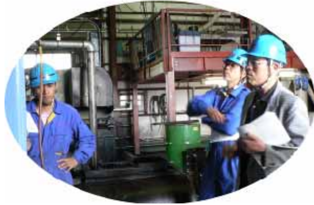
工場内設備を点検中
