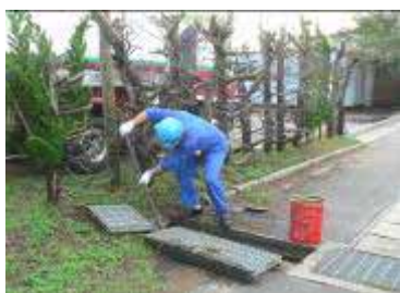
側溝の掃除も定期的に実施し、汚泥を取り除きます。
