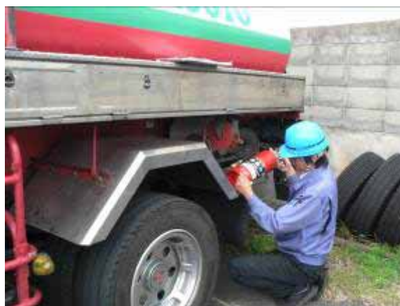
消火器の点検を行っています。（1年に1回有資格者が行っています。）
