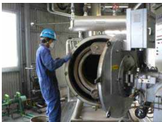
ボイラー内清掃中
