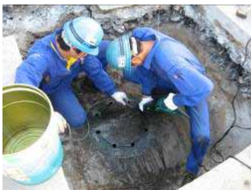
タンク穴あけ作業中。
