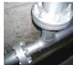
写真3 配管溶接部塗装状況
