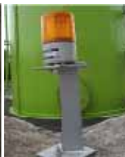
写真2 満油警報盤(左写真)と満油警報ランプ
