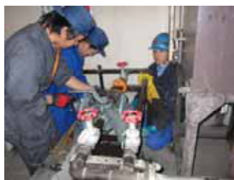
ボイラー会社の方々と 現地での調査中。
