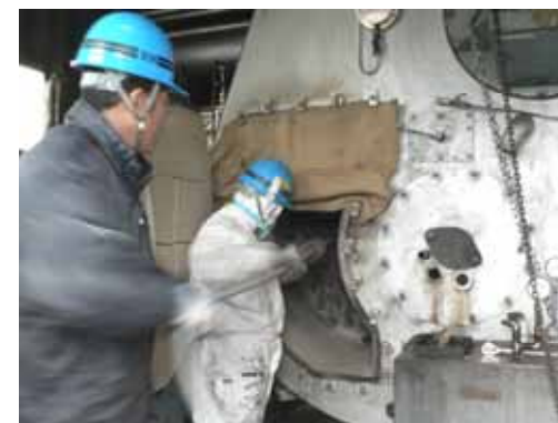
ボイラー内炉筒煙管の掃除。
