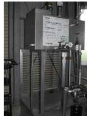
オイルサービスタンクと、防油堤
