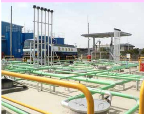
本社構内写真。原料・製品とも地下タンクに貯蔵され、配管は露出になっています。これにより、安全が確保されています。
