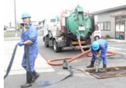
松江営業所の分離槽清掃中
