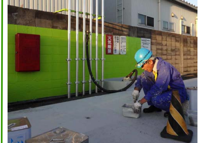
松江営業所の環境整備が進んでいます。福島シニアマネージャーの丁寧な作業により、地下タンク注入口近辺、構内入り口の白壁がとてもきれいになりました。ありがとうございます。
