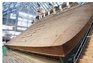
新しい檜皮葺きが終わった御本殿大屋根。(HPより引用しました)
