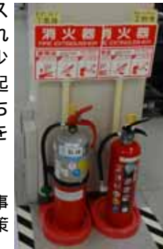
工場には気体と粉体の消火器が設置されています。
