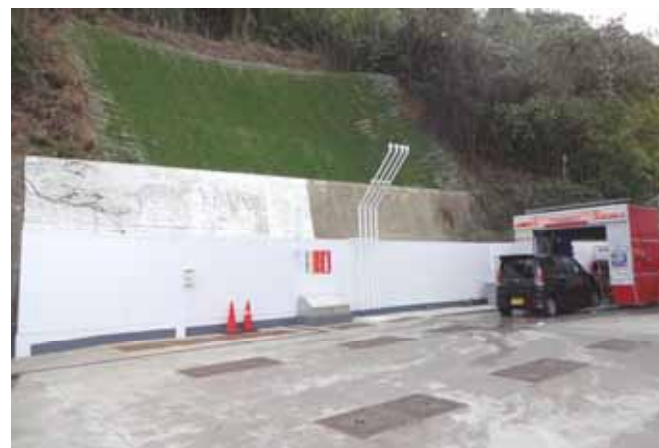
復旧工事が終わり、とても立派になった防火壁、通気管、洗車機です。
