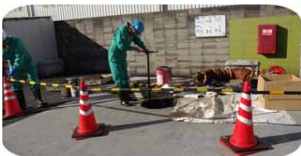
タンク清掃が終了し、復旧中。
