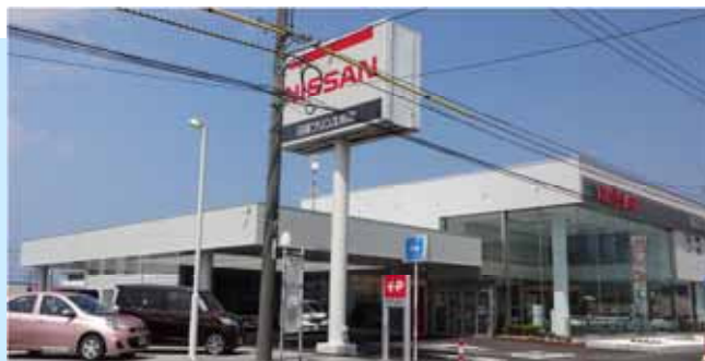
店舗全景。大きなキャノピーで雨・風を防ぎます。
