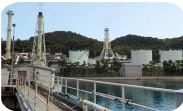
西郷発電所全景
