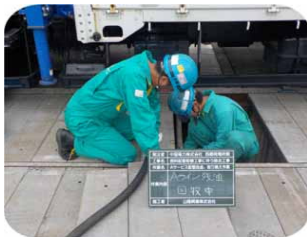
配管内残油回収作業の様子
