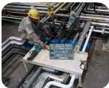
配管取替作業の様子
