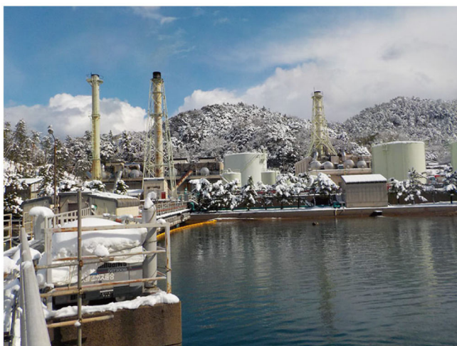
雪の西郷発電所
